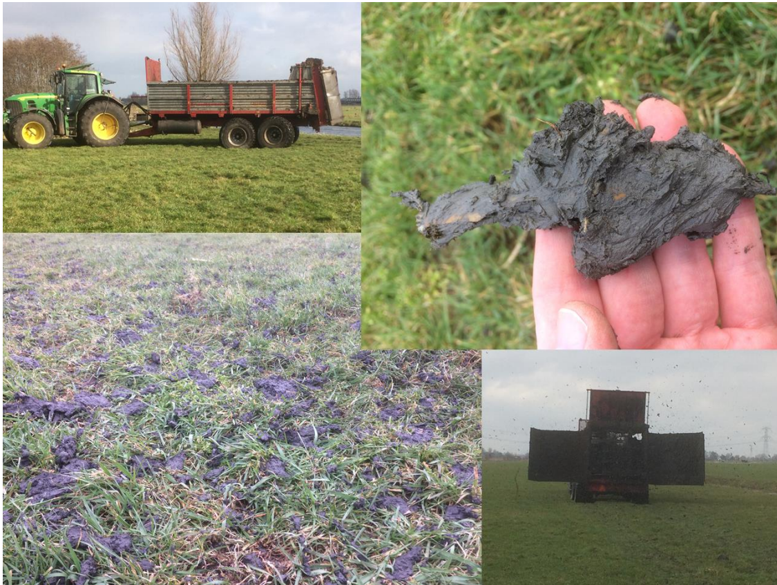
Afbeelding 3. Steekvaste kleibagger verspreiden met een breedstrooier op 28 februari 2019. Geschatte dosering op foto linksonder ruim 20 m 3 kleibagger per hectare.
