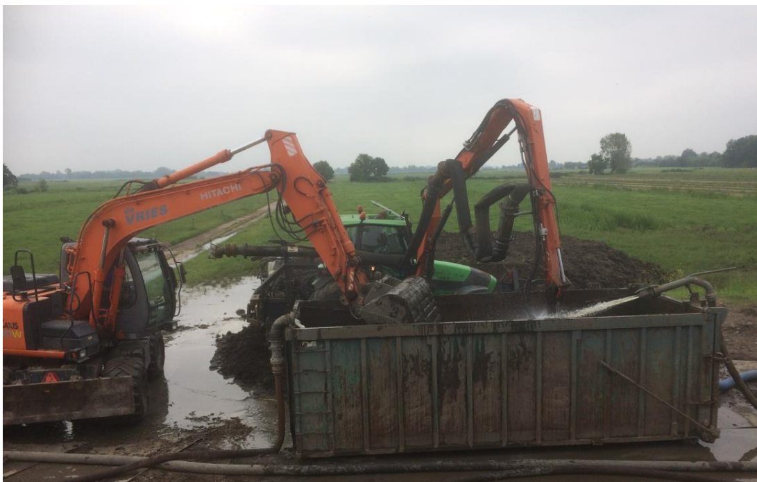
Afbeelding 10. Het maken van kleimelk batches in een container van ca. 7 m 3 kleibagger en 14 m 3 water (verhouding 1:3) met een mobiele kraan en trekker met baggerpomp duurde ca. 15 minuten.
