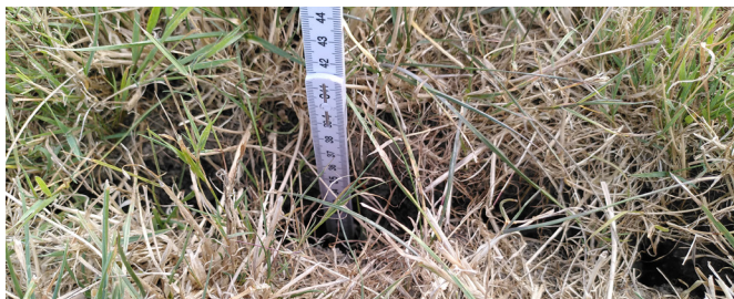
Onder droge omstandigheden ontstaan door het snijden met de zodenbemester scheuren tot wel 40 cm diep.
