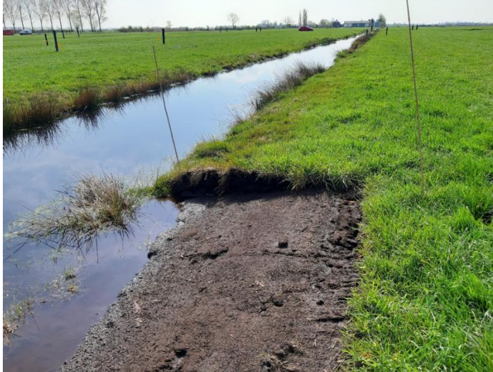
Afbeelding 2. Aanzicht van een net afgegraven oever op 14 april 2022; het raster is nog niet geplaatst.
