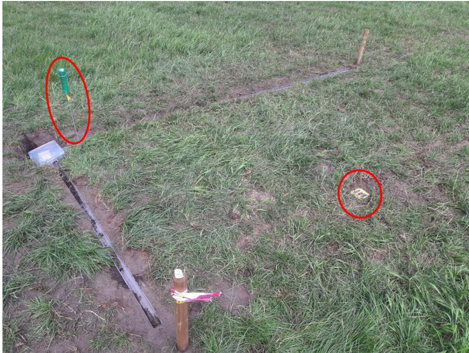
Figuur 3.7. Proefopstelling tijdens de zomerproef. Rood omcirkeld links een regenmeter en rechts een peilbuis (afgewerkt onder maaiveld). Tijdens de zomerproef zijn gootjes en een verzamelbak ingegraven in een poging om oppervlakkige afstroming op te vangen.
