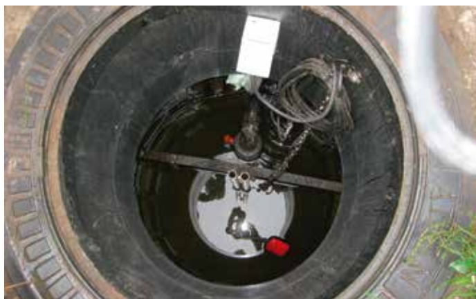
Verzamelput voor peilgestuurde drainage.
