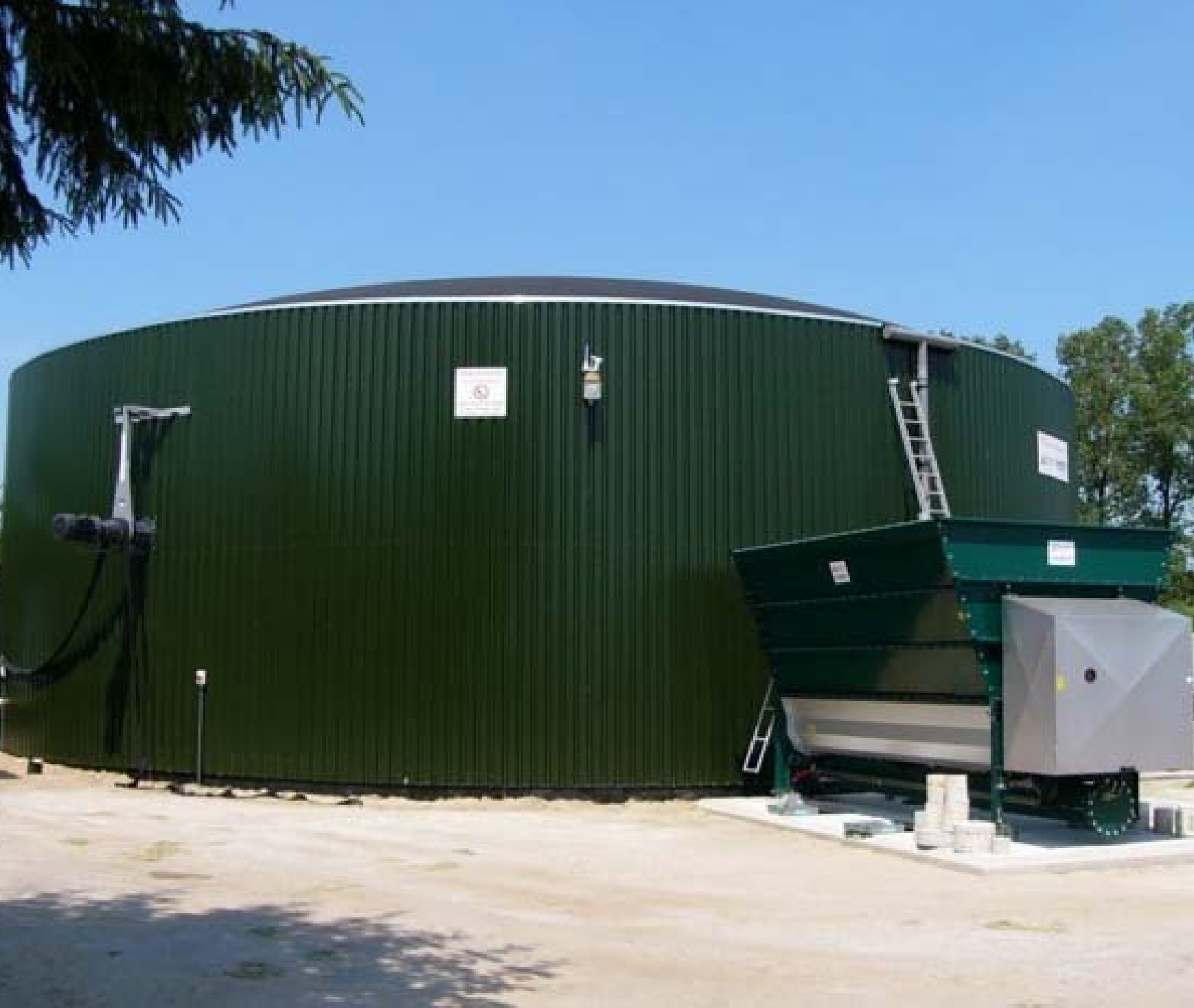
Biogas installatie Kraanswijk
