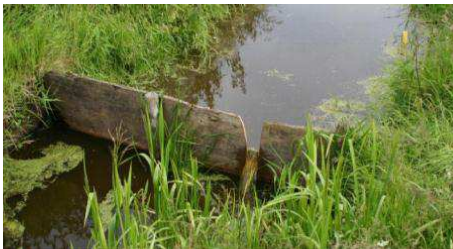
Middels een schot werd het peil van de sloot naast het perceel verhoogd.
