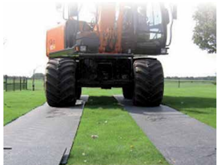
Rijplaten gebruiken op de laadplek kan zware schade aan de bodem voorkomen
