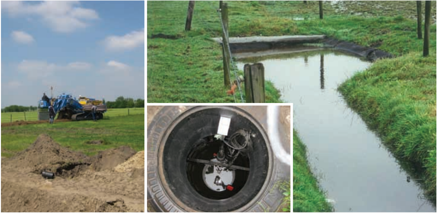
Foto links: aanleg infiltratiedrains, onder: de pompput, rechts: het grindfilter na een zware bui
