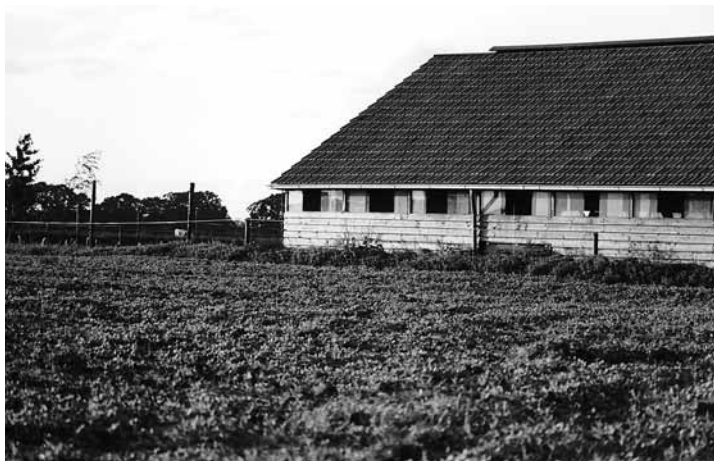
Bij deze stal worden daglicht en natuurlijke ventilatie met elkaar gecombineerd; de glazen platen zijn makkelijk open en dicht te schuiven.
